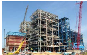
2013年8月27日，电厂一号锅炉成功通过水压测试
