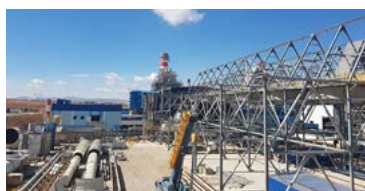
Ain Arnat 1,200MW 联合循环电厂 工程总包：韩国现代工程建设公司
